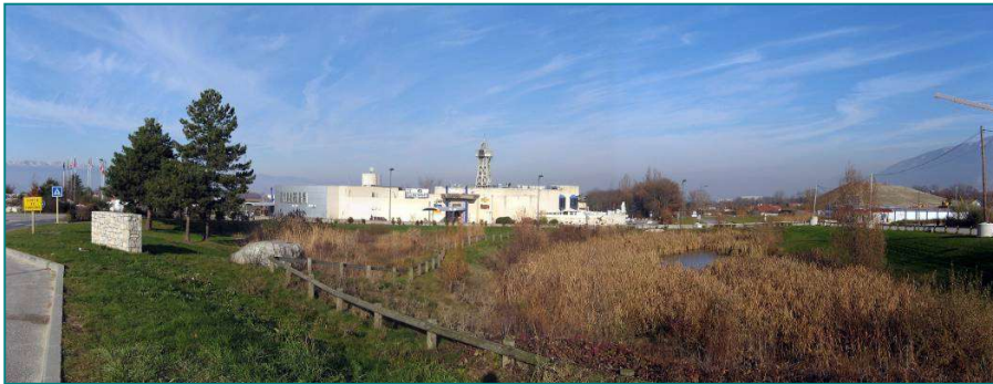
Exemple d'un bassin de retenue d'une zone d'activités à Neydens (74). Les eaux pluviales sont épurées par un filtre à roseaux avant d'être rejetées dans le milieu naturel.
