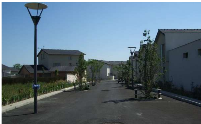
Exemple d'aménagement visant au partage des usages sur la voirie
