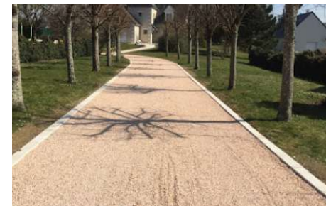
Chemin piéton en stabilisé, perméable aux eaux pluviales
